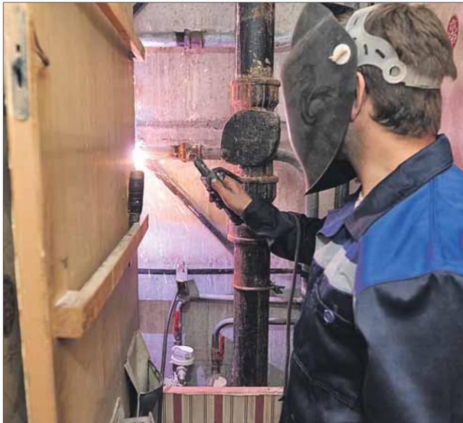
При установке новых труб важно проверить стыки
